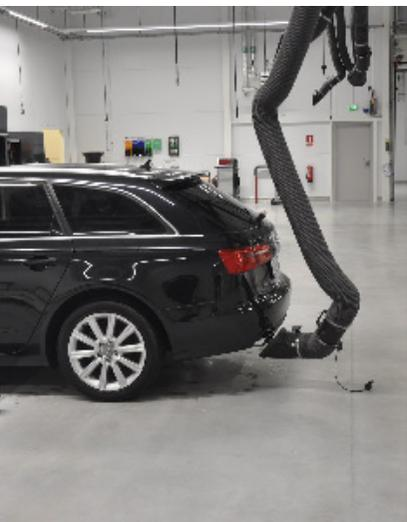
I bracci TOUCHLESS della serie GTL sono la soluzione più avanzata per l'aspirazione dei gas di scarico prodotti da ogni tipo di veicolo, a prescindere dalle dimensioni e dalla posizione dei tubi di scarico.
